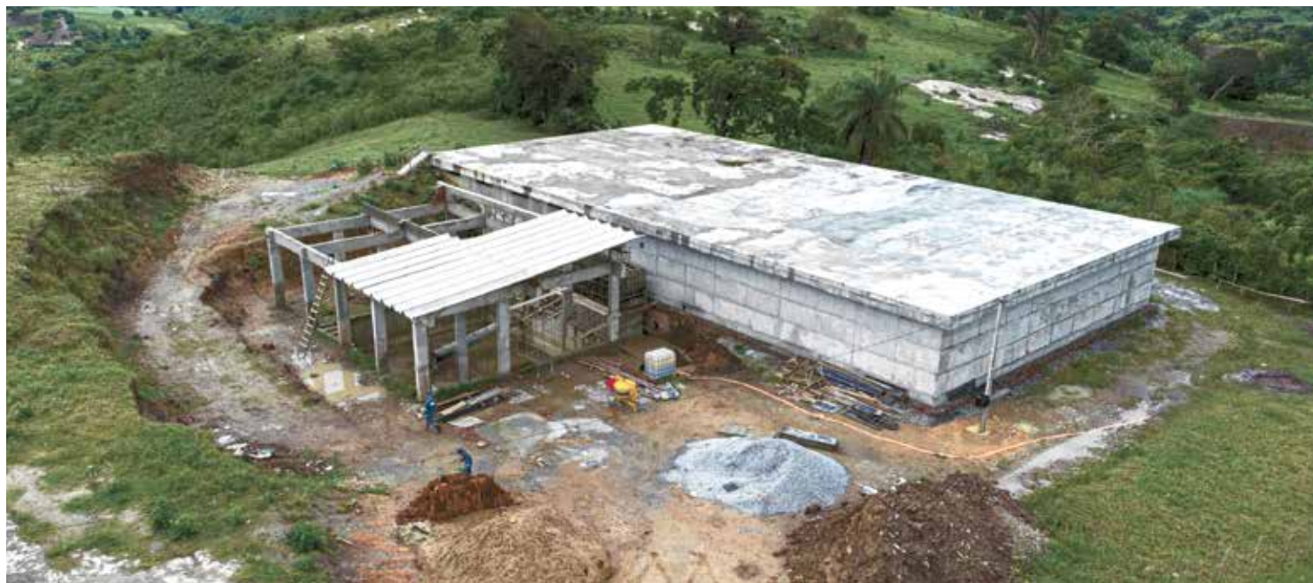
Adutora vai beneficiar diretamente 12 municípios do Brejo paraibano com o equacionamento do fornecimento d'água frente à estiagem
